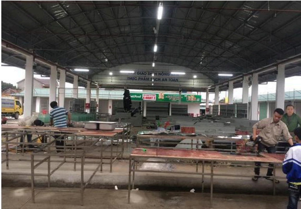
Các công nhân cuối cùng đang hoàn thiện sàn
